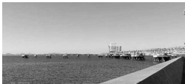
LNG船の受入設備
